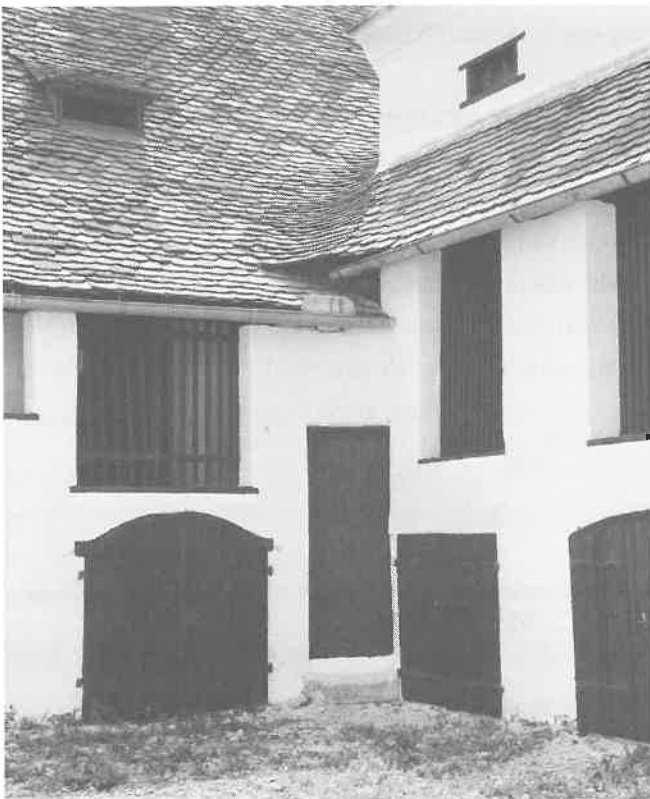
Die südwestliche Taborecke nach der Renovierung 1984
