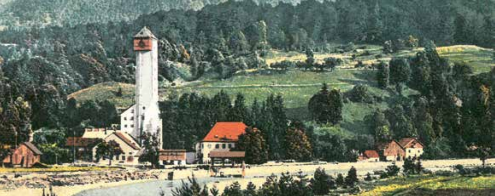
Ansicht des Schrotturmes und der ihn umgebenden Anlagen um 1890.
