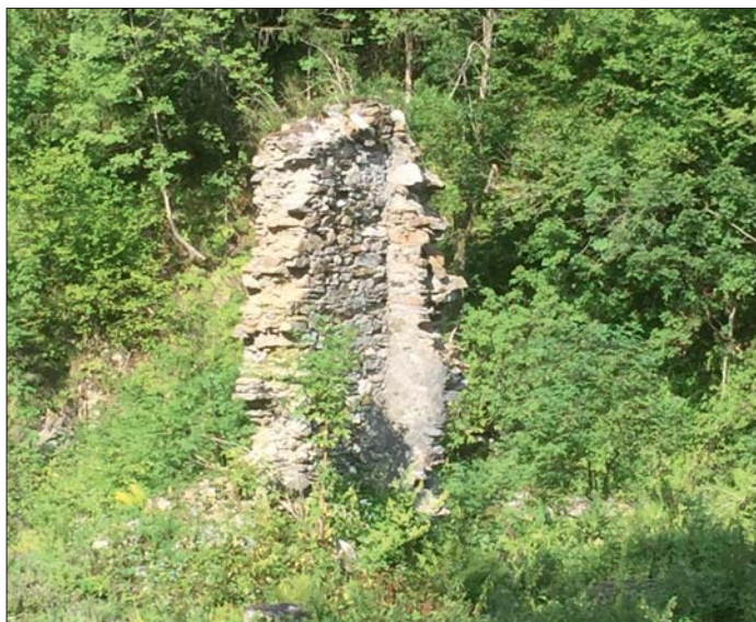
Im Korpitsch-Graben erinnern heute nur noch einzelne Mauerreste an die einstigen Anlagen, in denen Eisen verarbeitet wurde (© Wiesflecker)
