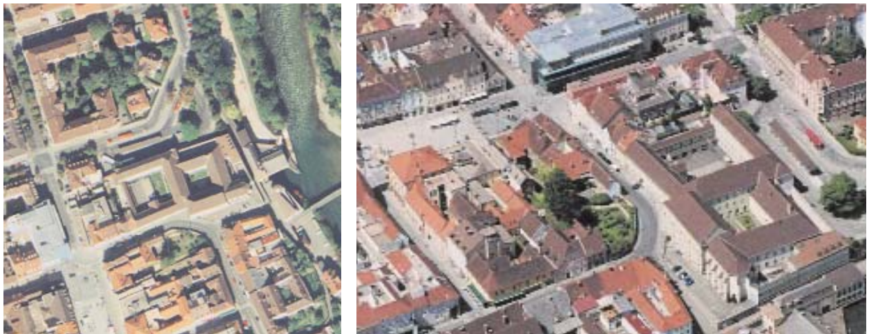
501., 502. Leoben, ehem. Dominikanerkloster, digitales Orthophoto und Schrägansicht von Südost 2003
