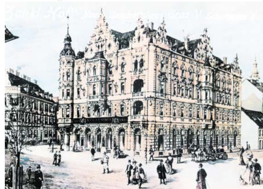
Der Zankl-Hof (1908, Planung Hans Pruckner), Maria-Stromberger-Gasse 2, einst Verwaltung und Geschäft der „Farben- und Lack-Werke A. Zankl Söhne“, nun Stadtbibliothek Graz.
