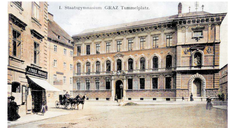
Das Akademische. Das 1890 erbaute Akademische Gymnasium auf einem Foto um 1900.
