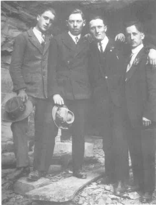
Das Foto entstand 1932 und zeigt die Arbeiter Leo, Konrad und Robert sowie den Sohn des Steinbruchbesitzers Hans Ortner (2. v. l.) vor einem „Mundloch“ (Zugang) des untertägigen „Sunfixl-Steinbruches“
