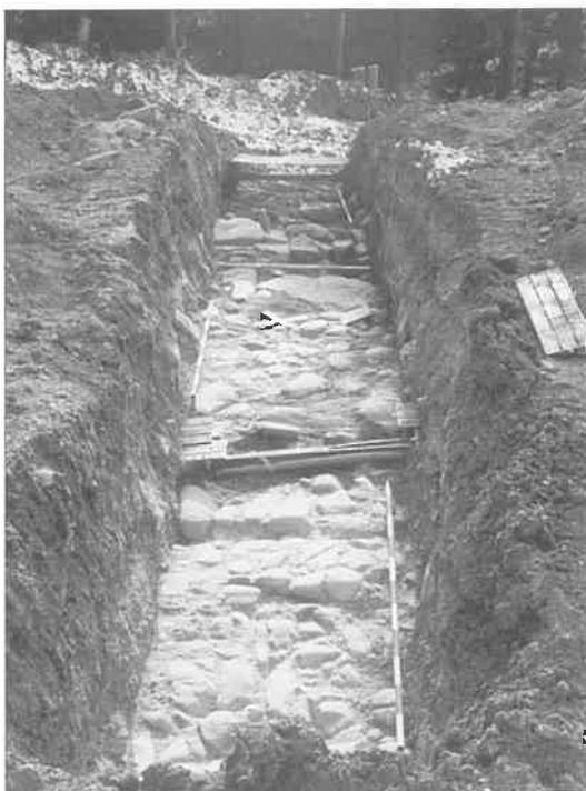
*Abb. 2: Die neue Commercialstraße mit Erzweg und seitlichem Fundament am talseitigen Straßenrand. Polster/Vordernberg Schnitt 3/1998 (Archäologie & Communication, Dr. Susanne Klemm)*
