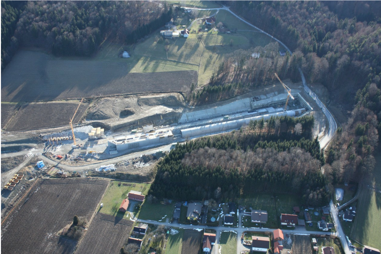
Abb. 80: Freidorf an der Laßnitz, Koralmtunnel-Ostportal, offene Bauweise, Tunnelröhren im Bau, Ansicht gegen Süd, Luftbild ARGIS, 03.01.2010.
