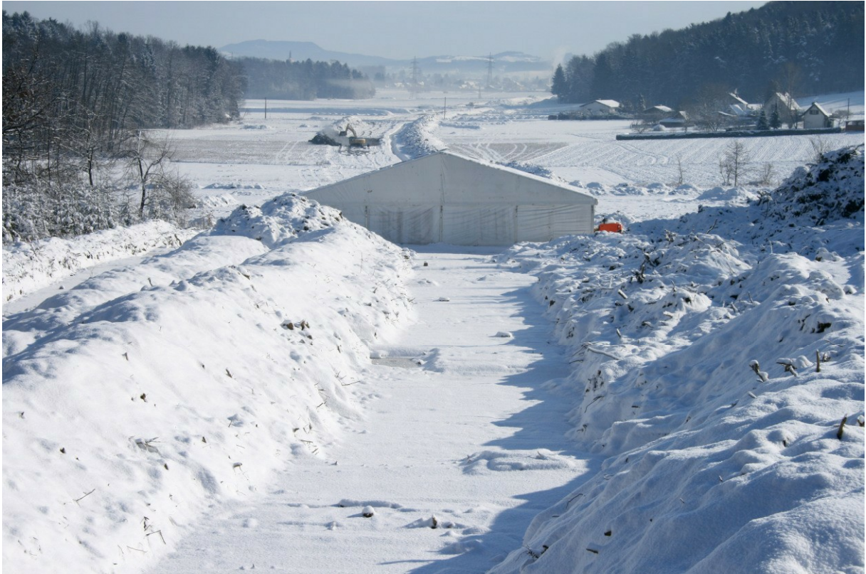
Abb. 77: Freidorf an der Laßnitz, Zelthalle über Objekt 56. Ansicht gegen Ost, Foto ARGIS, 18.02.2009.
