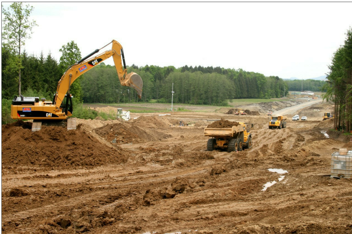
Abb. 79: Freidorf an der Laßnitz, Koralmtunnel-Ostportal, Ansicht gegen Ost, Beginn des Erdbaus nach Abschluss der Grabung. Foto ARGIS, 05.05.2009.
