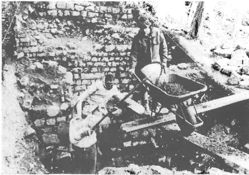
Freilegung eines romanischen Mauerwerks von Alt-Wildon, 1986
