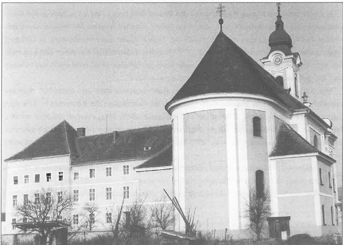
Ehemaliges Piaristenkloster in Gleisdorf mit Marienkirche, Westseite, 1976.
