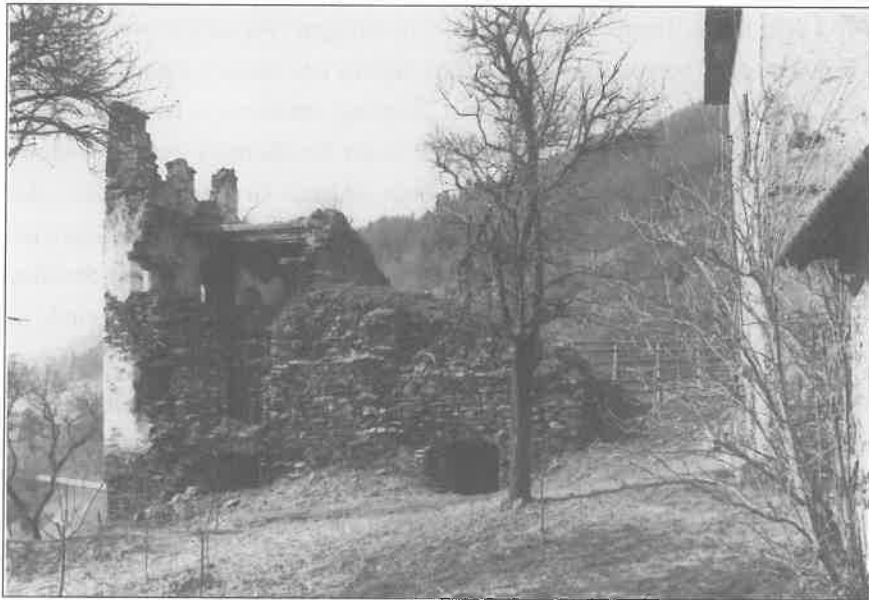
Irenfritzhof in der Gemeinde Falkendorf bei St. Ruprecht ob Murau vor dem Abtragen der Mauerreste. Nun blieb das Erdgeschoß erhalten. Der Irenfritzhof ist 1355 urkundlich erstmals genannt und war seit 1416 Zehenthof des Erzbischofs von Salzburg.
