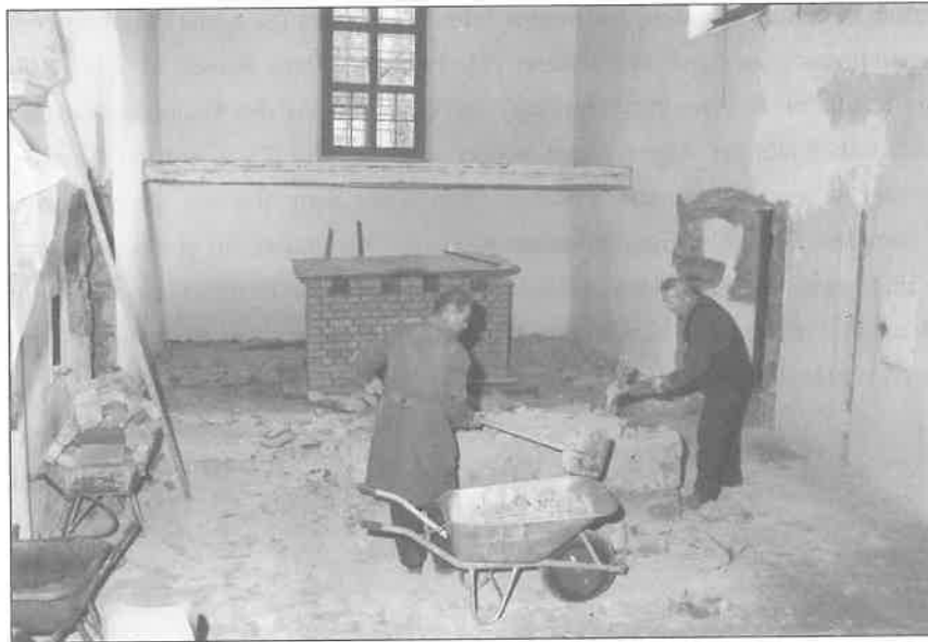
Kapuzinerklosterkirche Murau 1991. Die Mensa des ehem. Hochaltars wird soeben abgetragen, nachdem die neue Mensa für den Hochaltar 3,5 m nördlich bereits aufgebaut worden ist (Mai 1991).
