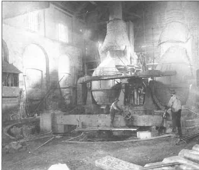
Abb. 6: Zeltweg, Bessemerstahlwerk (Teil des Oberen Werkes) mit zwei Konvertern. Undatierte Aufnahme (um 1880) im Besitz von H. J. Köstler.
