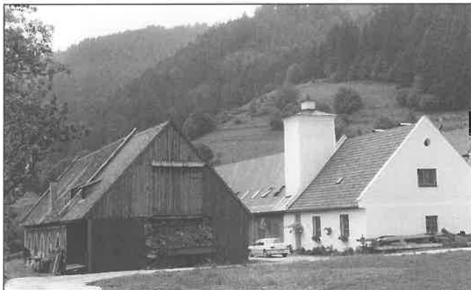
Abb. 7: Möderbrugg, Ehemaliges Hammerwerk Horn mit Stahlerzeugung im Frischherd (Frischhütte). (Aufnahme: H. J. Köstler, 1993)
