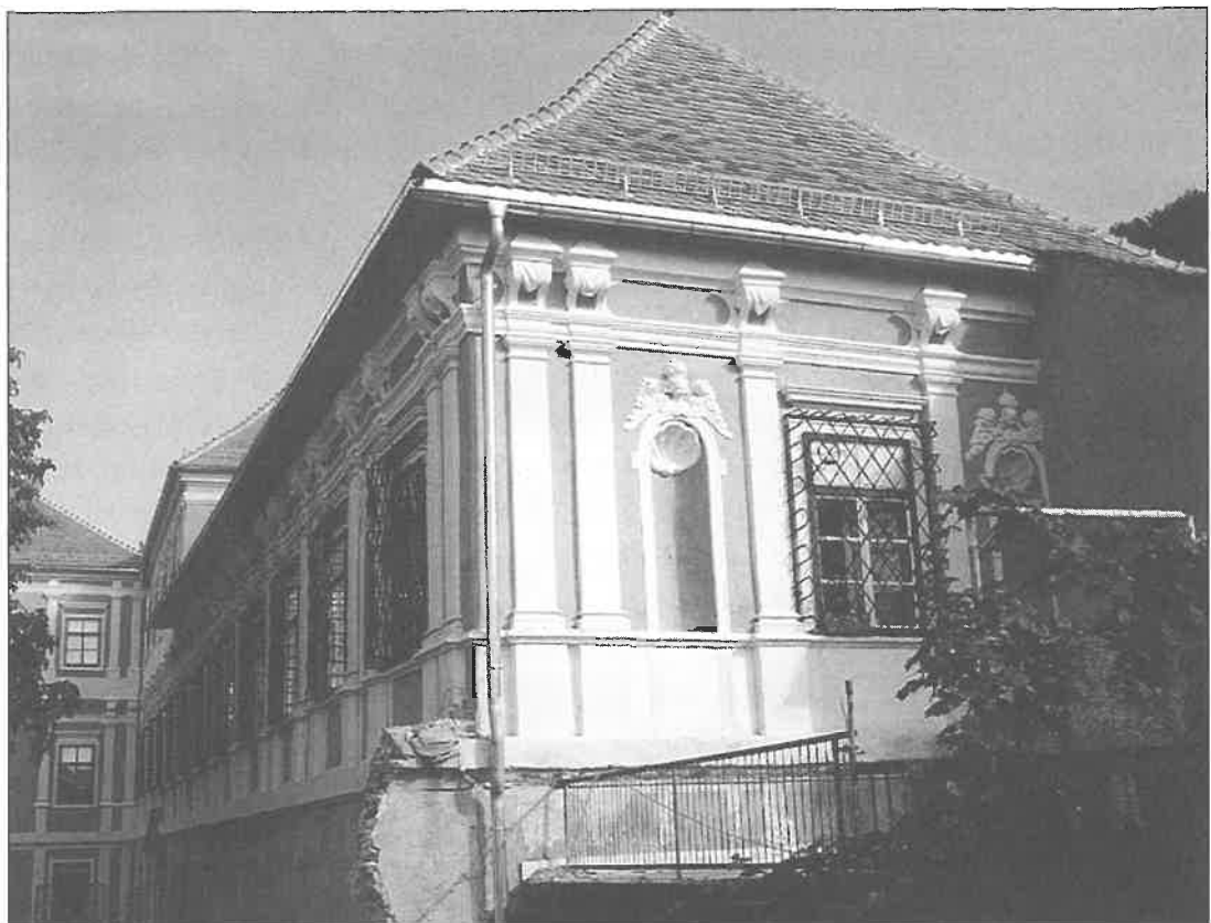
Restaurierte Fassade des Unteren Schlosses Wildon.
