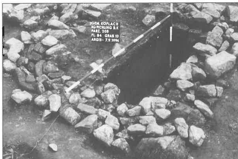
Abb. 1: Fundament eines römischen Grabbaus in Köflach-Pichling. (Foto: ARGIS - G. Fuchs)
