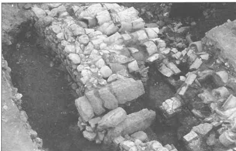
Abb. 3: Heißluftkanal als Verbindung zwischen Feuerung und Hypokaustum.
