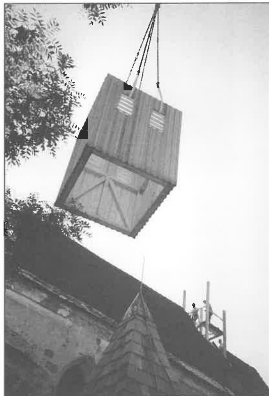
Montage des Dachreiters der Georgibergkirche, 1999.
