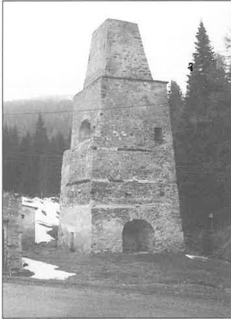
Abb. 2: Schmelz bei Judenburg. Im letzten Drittel des 18. Jahrhunderts erbauter Hochofen (Floßofen); Höhe des eigentlichen Schmelzofens: vom Hüttenflur bis zum ersten Mauerabsatz, darüber zweistufige Rauchhaube. (Aufnahme: H. J. Köstler, 1997)
