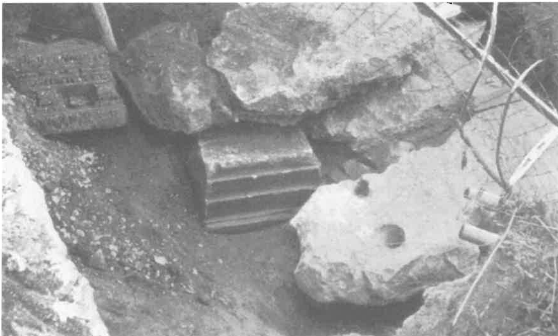
Mauer einer spätantiken Fluchtburg auf dem Frauenberg bei Leibnitz, die aus Bruchstücken römerzeitlicher Bauten errichtet wurde.
