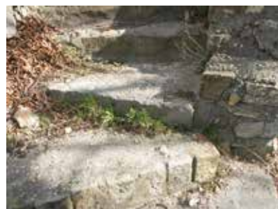
Abb. 88 Großer Palas Südwestecke, Detail Stiegenaufgang, spoliierter Fensterlaibungsstein
