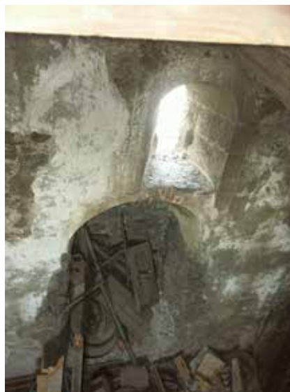
← Abb. 81: Nordmauer untere Burg- kapelle innen, vermauertes frühneuzeitliches Fenster, darüber das 1966 wieder geöffnete Doppeltrichter- fenster
