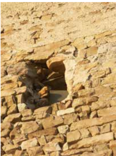
Abb. 90: Südliche Ringmauer der Kernburg, Detail oberes Schlitzfenster
