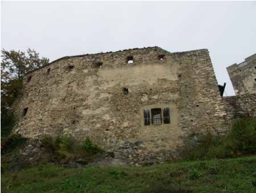
← Abb. 89: Südliche Ringmauer der Kernburg, Handquadermauerwerk mit zwei primären Schlitzfenstern; auf Höhe des ehem. Wehrganges abwechselnd Schießscharten und Wurföffnungen aus dem 16. Jh.; im Erdgeschoß ein vom Burgverein wieder errichtetes Fenster
