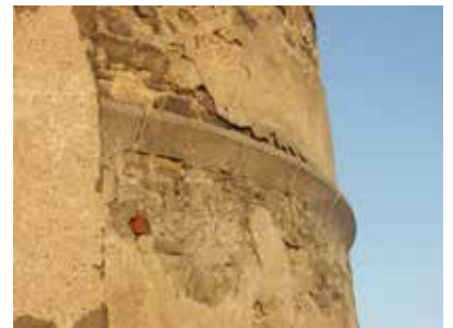
← Abb. 80: Südfassade Burgkapelle, barockes Rundbogenfenster mit halbseitig vermauertem Rest eines romanischen Doppeltrichterfensters
