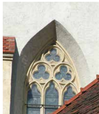
Abb. 45: Leechkirche Graz, Steiermark, Detail Südfenster des 5/8 Schlusses mit Kehlstäben als Fensterpfosten (siehe dazu Abb. 37)
