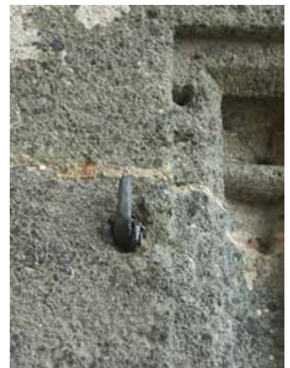
Abb. 40: Kernburg der Riegersburg, Steiermark, Detail von verstärktem spätgotischen Fenster, Fensterbalken- Angel in rechteckigem Loch des Gewändes befestigt (siehe dazu Abb. 37)
