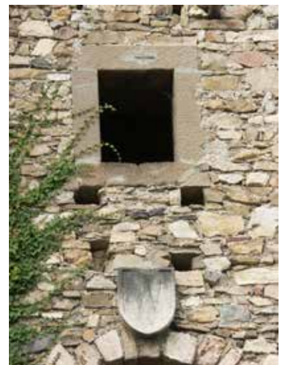
Abb. 92: Inneres Burgtor über dem Torbogen, vom Burgverein wieder errichtete Fensteröffnung mit darunter sitzendem Wappen der Familie Attems aus Kunststein
