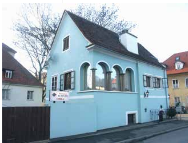
Abb. 99: Abb. 99: Frankstraße 44, Graz, Steiermark, wieder verwendete Säulen vom abgebrochenen Haus Hauptplatz 14 Graz
