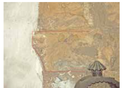
Abb. 32: Ruine Gösting, Nordostecke der oberen Burgkapelle, Kämpferstein in situ
