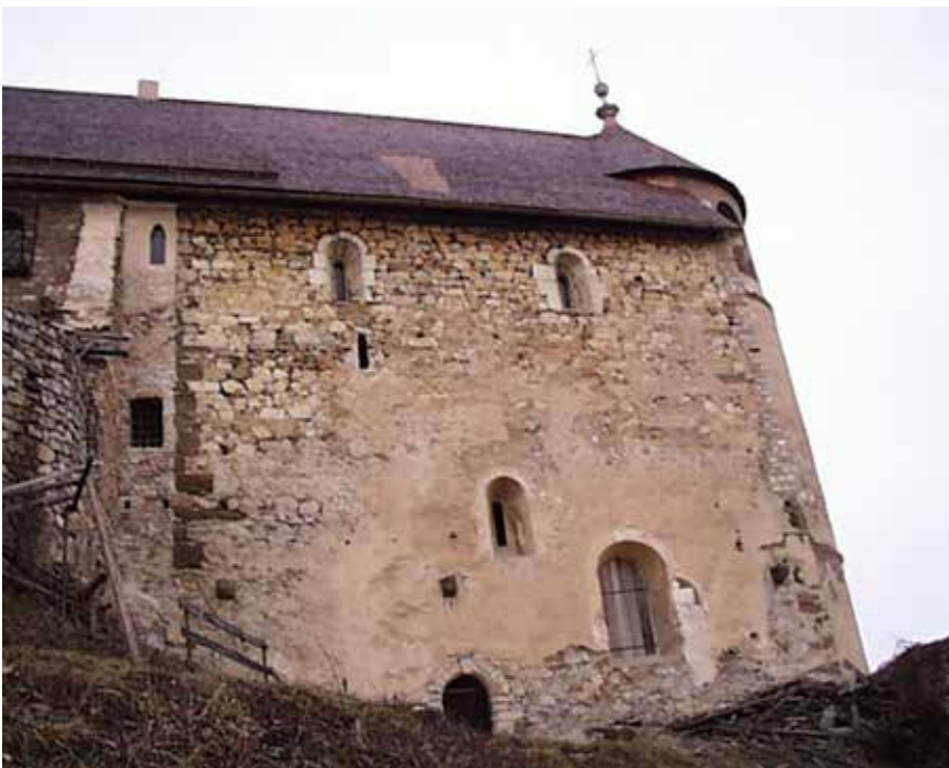
Abb. 77: Südfassade Burgkapelle mit drei originalen Doppeltrichterfenstern, einem durch den Einbau eines frühneuzeitlichen Rundbogenfensters nur noch halbseitig erhaltenen und mit Spolien vermauerten Doppeltrichterfenster. Die Eckquader beim Choreinzug wurden nach einem Blitzschlag vom Burgverein 1971 erneuert.
