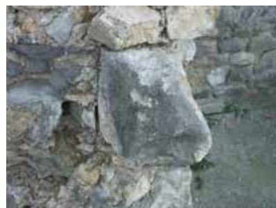
Abb. 86: Großer Palas im Anschluss an den Wohnturm, teilweise frei gelegte Spolie in einer abgebrochenen Quermauer
