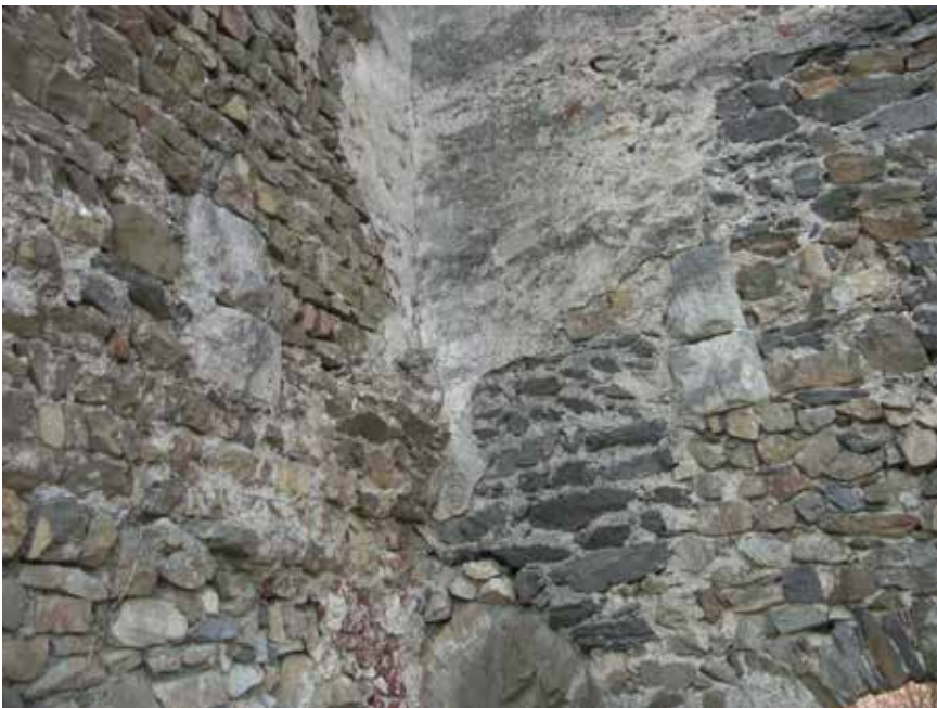
Abb. 95: Fünfeckturm Westseite mit anschließender Quermauer zum Knappenhaus, vier an der Oberfläche abgearbeitete Hausteine
