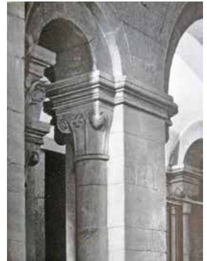
Abb. 16: Dom Gurk, Kärnten, Kapitell in der Vorhalle
