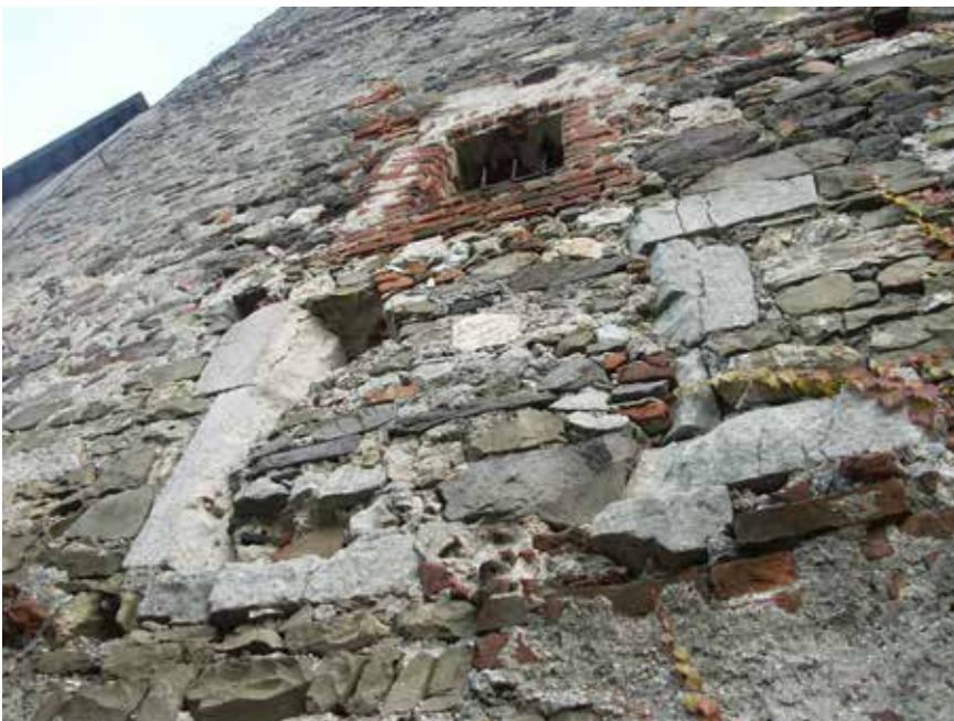
← Abb. 82: Wohnturm Nordwestfassade, vermauerter Hocheinstieg im EG mit sekundärem Fenster
