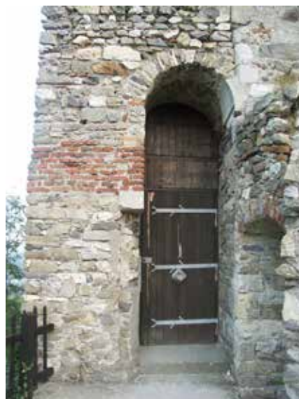
Abb. 83: Wohnturm Nordwestfassade, jüngerer vermauerter Hocheinstieg im 1. OG
