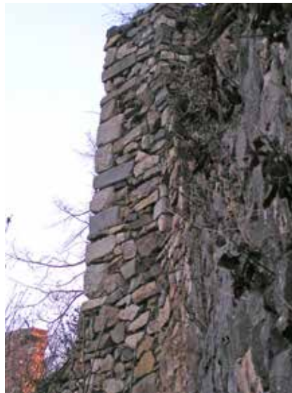
Abb. 94: Nördlich dem Fünfeckturm vorgelagertes Vorwerk, vom Burgverein mit Spolien errichtete Mauerecke
