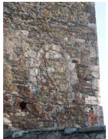
Abb. 83: Wohnturm Nordwestfassade, jüngerer vermauerter Hocheinstieg im 1. OG
