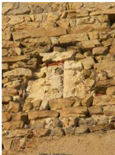
Abb. 91: Südliche Ringmauer der Kernburg, Detail unteres Schlitzfenster
