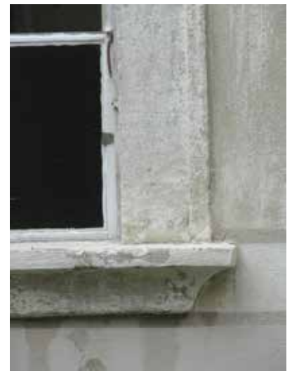
Abb. 55: Benediktinerstift Altenburg, Niederösterreich, Brunnenhof Westtrakt Ostseite 1654/56, Detail Fenstersohlbank
