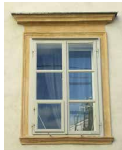
Abb. 64: Burggasse 7, Graz, Steiermark, Fenster mit eingeschobenen Friesstreifen zwischen Horizontalverdachung und Laibungssteinen
