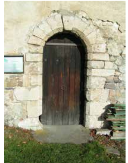
Abb. 76: Südfassade Burgkapelle, Eingangsportal mit linkem unterem Originalgewänderelement und den vom Burgverein neu eingesetzten Hausteinen
