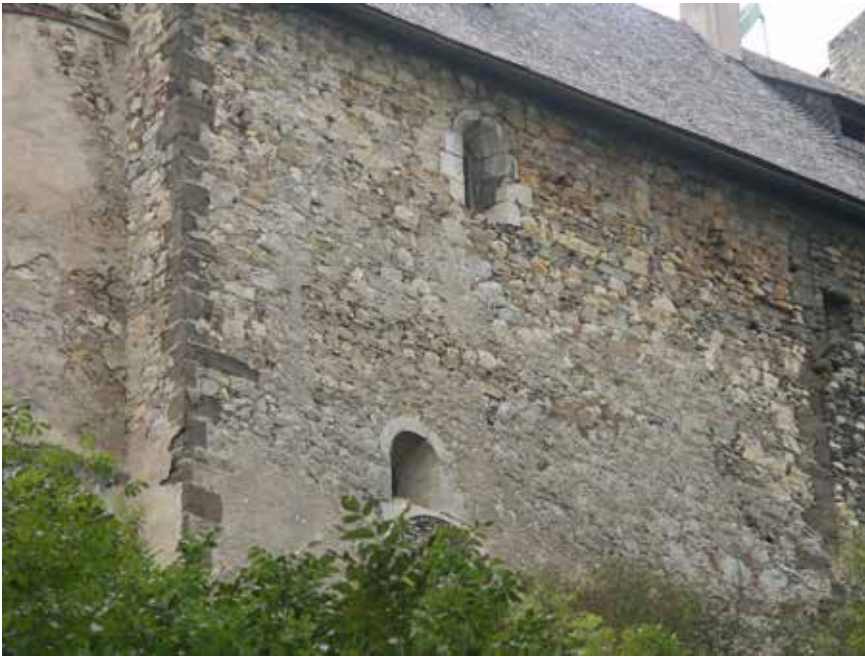
Abb. 75: Nordfassade Burgkapelle mit den originalen Eckquadern aus Kainachtaler Sandstein und den originalen Trichterfenstern aus Leithakalksandstein; das untere Doppeltrichterfenster ist im Sockel durch den Einbau eines frühneuzeitlichen Rundbogenfensters teilweise gestört
